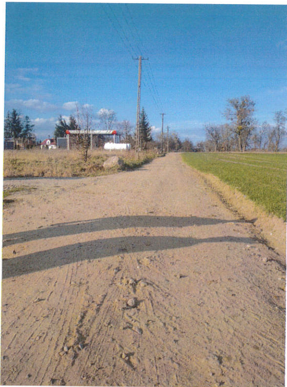
Fot. 1 zdjęcie od mieszkańca ul. Ostatniej
