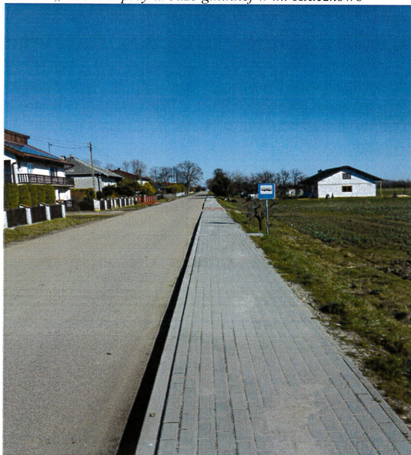
Zdjęcie nr 4 - „Chodnik przy drodze gminnej w m. Kłaczkowo”
