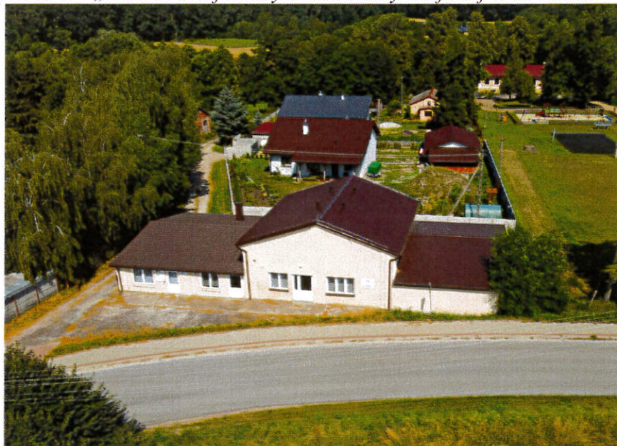
Zdjęcie nr 9 - „Modernizacja budynku świetlicy wiejskiej w m. Cieśle”
