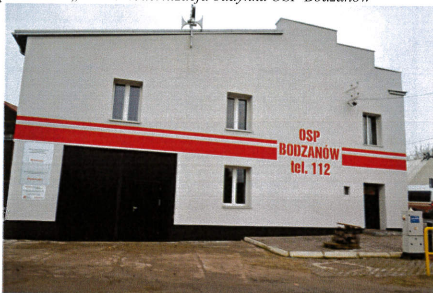
Zdjęcie nr11 - „Termomodernizacja budynku OSP Bodzanów”
