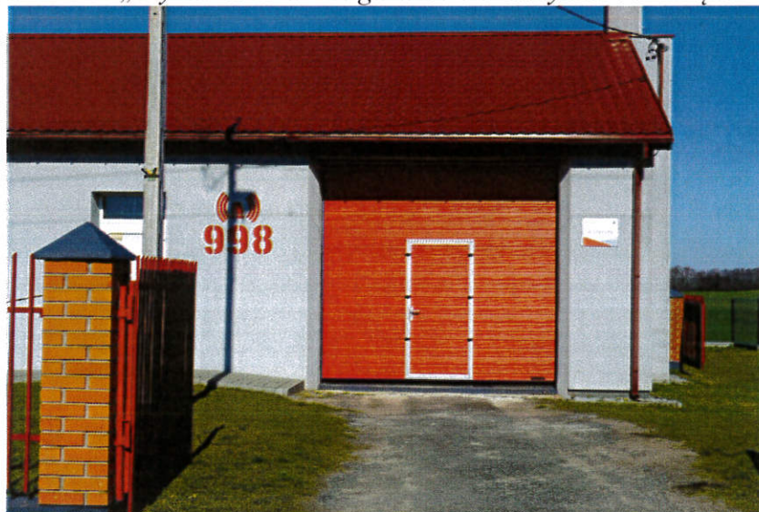
Zdjęcie nr 12 - „Wymienione drzwi garażowe w budynku OSP Mąkolin”
