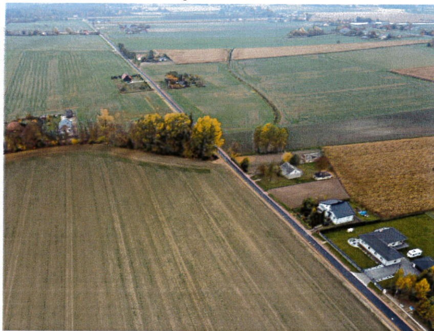
Zdjęcie nr 24 – „Odbudowa drogi Nowe Miszewo-Borowice”
