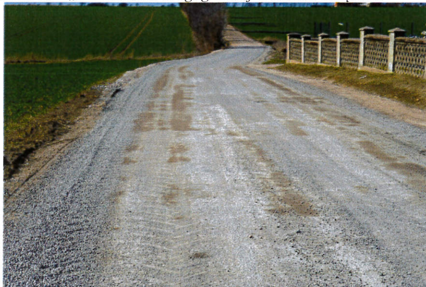
Zdjęcie nr 18 - „Przebudowa drogi gminnej w sołectwie Łętowo”
