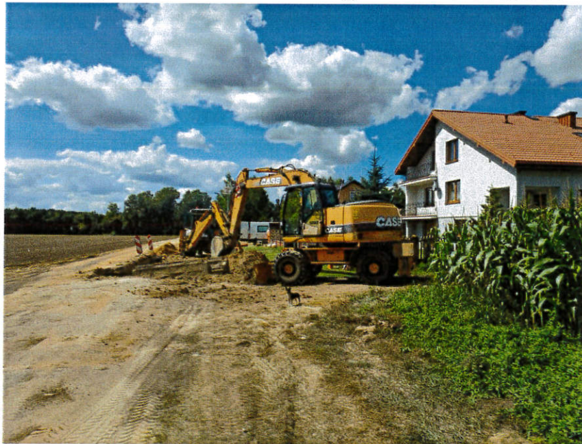
Zdjęcie nr 25 - „Rozbudowa sieci kanalizacyjnej w m. Nowe Miszewo”
