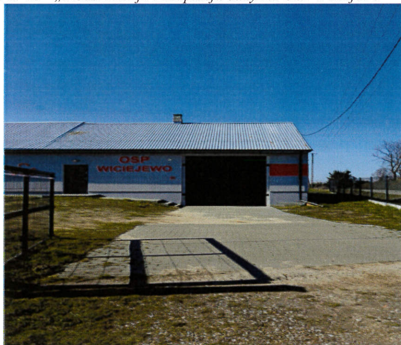
Zdjęcie nr 13 - „Modernizacja i adaptacja budynku OSP Wiciejewo”
