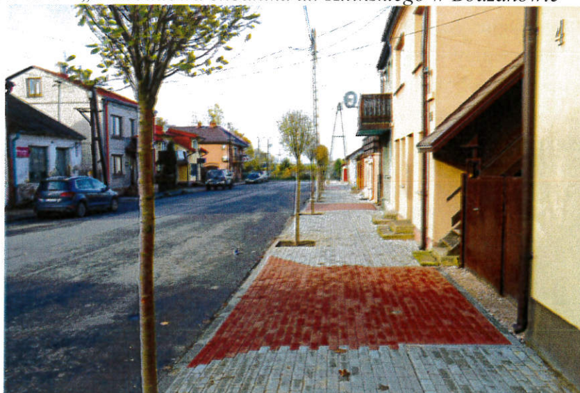
Zdjęcie nr 3 - „Przebudowa chodnika ul. Kilińskiego w Bodzanowie”
