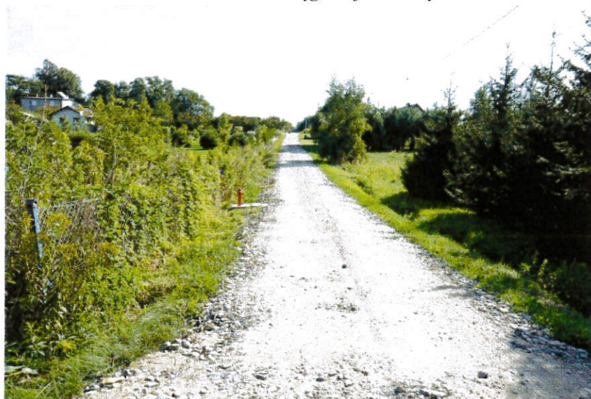
Zdjęcie nr 23 - „Budowa sieci wodociągowej w Nowym Miszewie”
