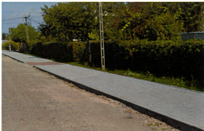
Zdjęcie nr 6 - „Przebudowa chodnika przy drodze gminnej w m. Chodkowo-Działki, przy ul. Kwiatowej”
