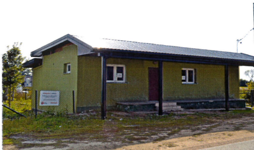
Zdjęcie nr 8 - „Modernizacja budynku świetlicy wiejskiej w m. Cybulin”
