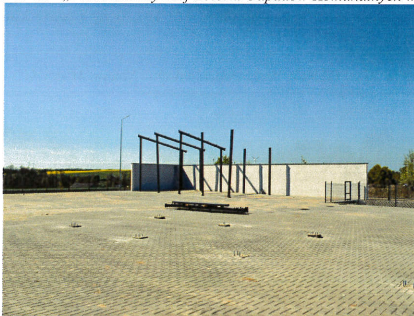
Zdjęcie nr 22 - „Punkt Selektywnej Zbiórki Odpadów Komunalnych w Chodkowie”
