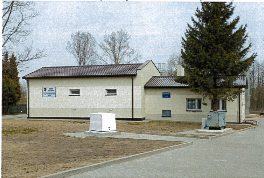
Zdjęcie nr 18 – „Modernizacja Stacji Uzdatniania Wody w Leksynie”
