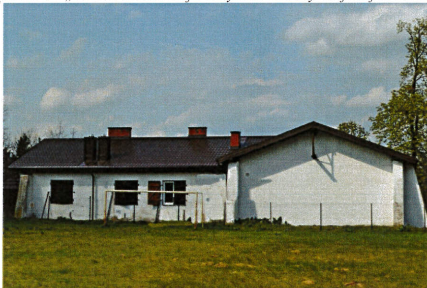
Zdjęcie nr 7 - „Termomodernizacja budynku świetlicy wiejskiej w Borowicach”
