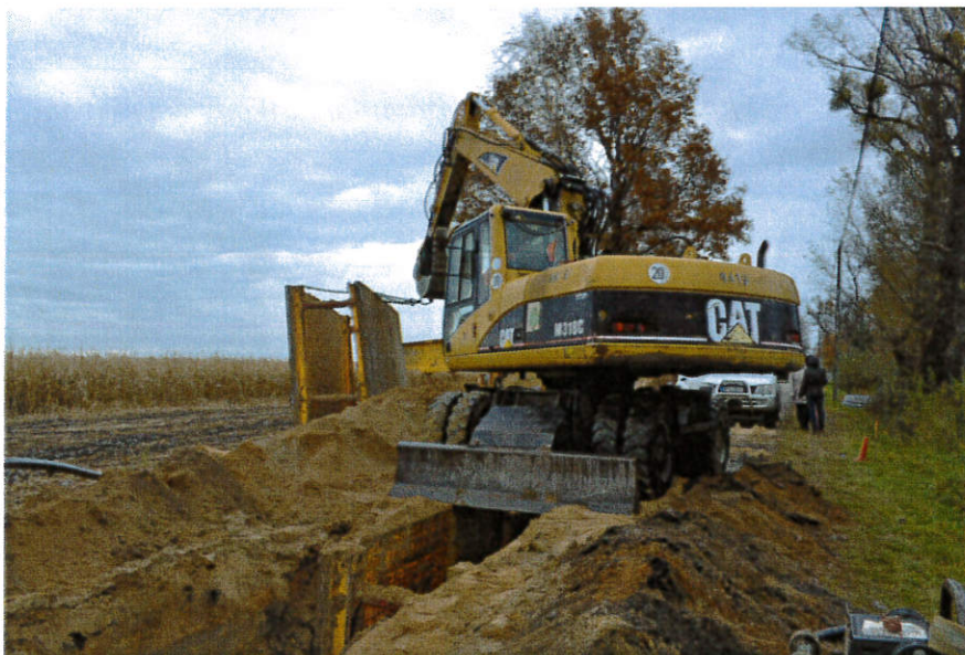
Zdjęcie nr 20 – „Budowa sieci kanalizacji sanitarnej w Chodkowie i Karwowie Duchownym”
