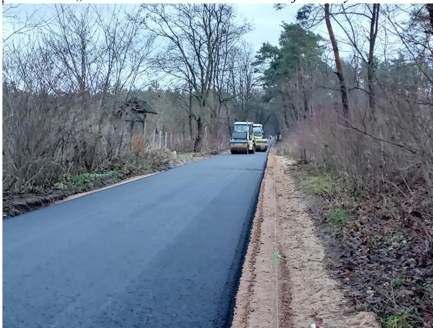
Zdjęcie nr 13 - „Odbudowa nawierzchni ul. Leśnej w Nowym Miszewie”
