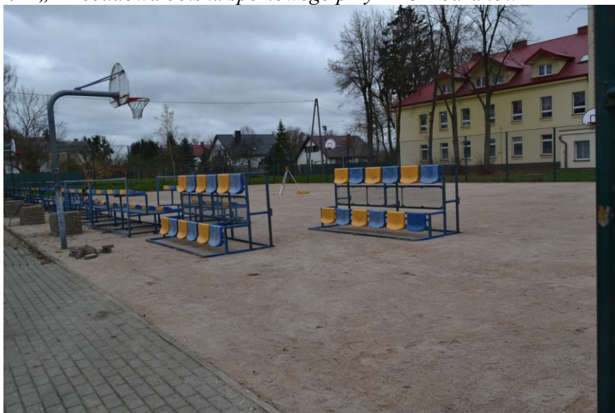
Zdjęcie nr 14 – „Przebudowa boiska sportowego przy ZPO Bodzanów”
