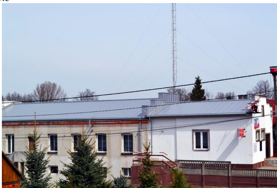
Zdjęcie nr 11 – „Modernizacja budynku Ochotniczej Straży Pożarnej w Bodzanowie”
