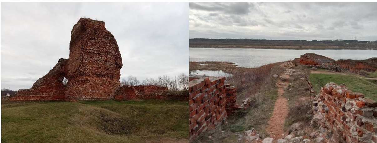
Ryc. 14. Niewykorzystywane ruiny Zamku w Bobrownikach
