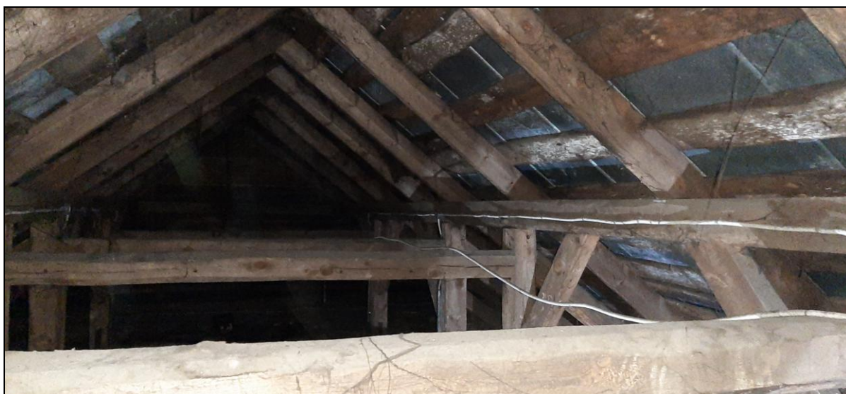
Widok konstrukcji więźby dachowej budynku A.
