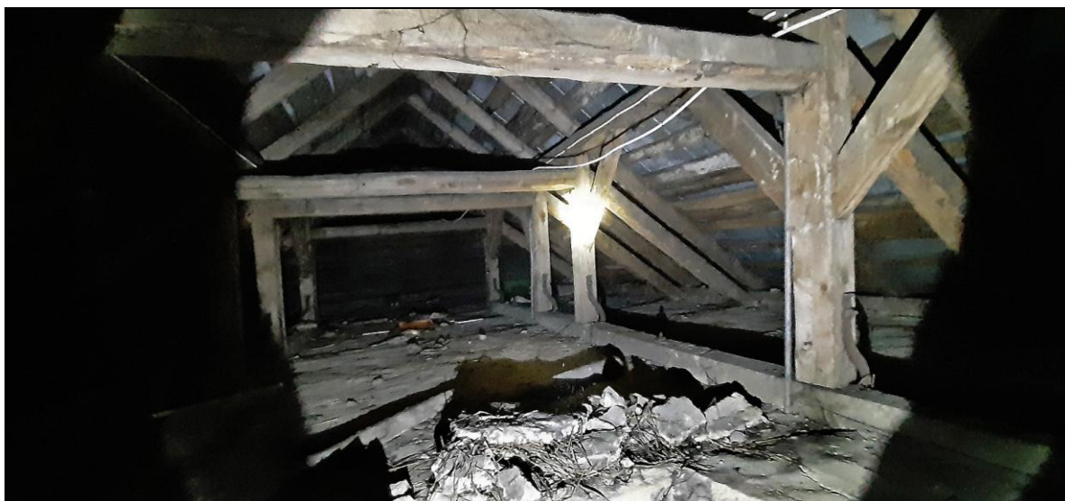
Konstrukcja poddasza nieużytkowego budynku A.
