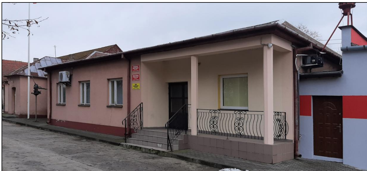
Wejście główne do budynku od strony parku.
