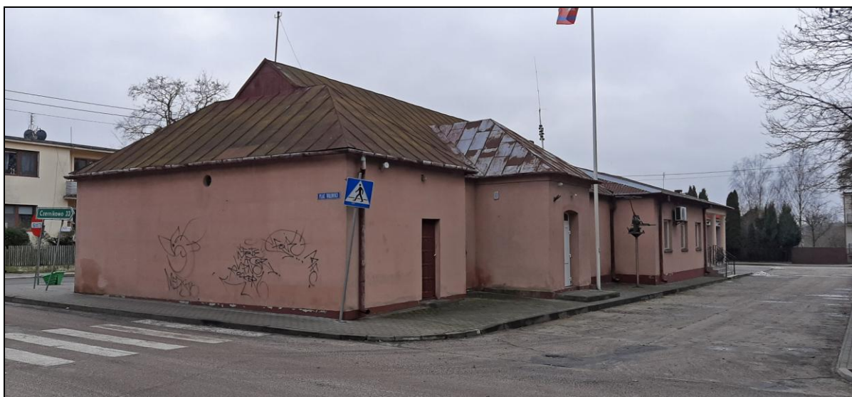
Widok budynku od strony ul. Lipnowskiej.
