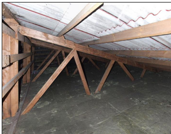
Widok konstrukcji więźby dachowej w budynku B.
