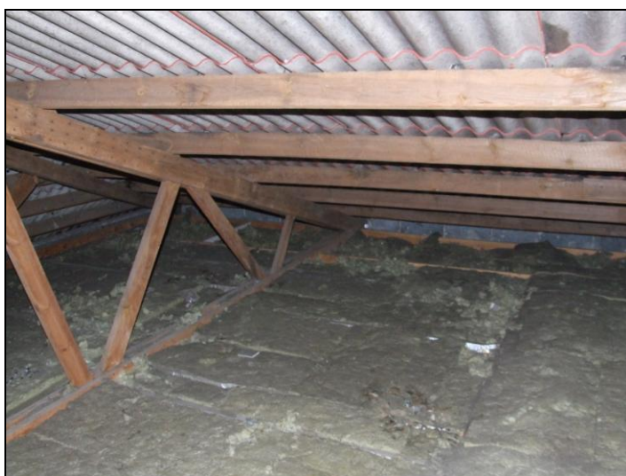
Widok konstrukcji więźby dachowej budynku B.
