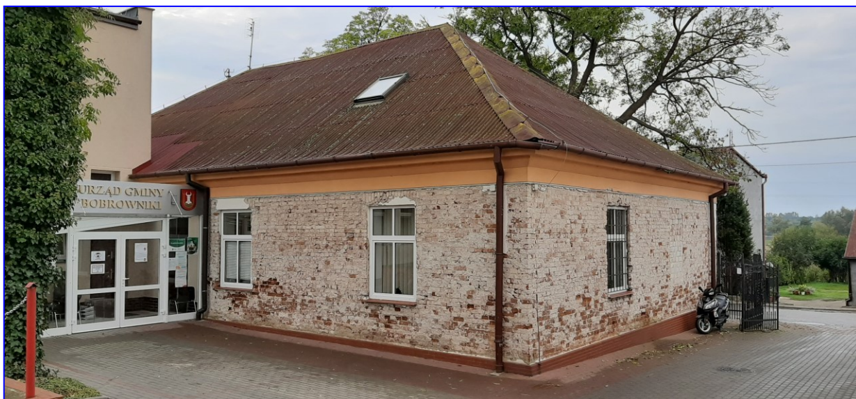
Widok dachu od strony wnętrza dziedzińca.
