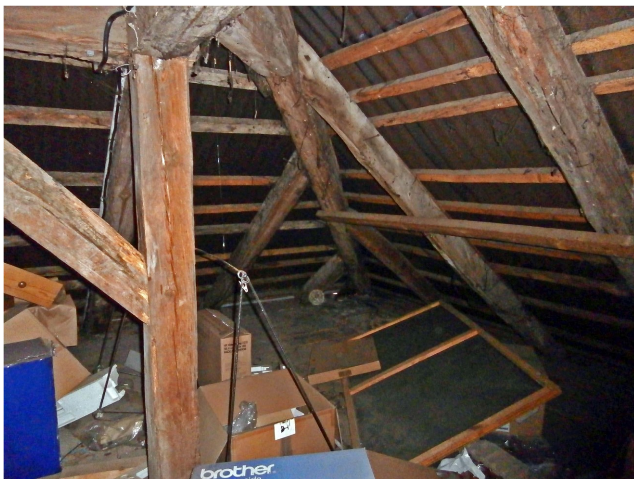
Widok niezabudowanej więźby dachowej.
