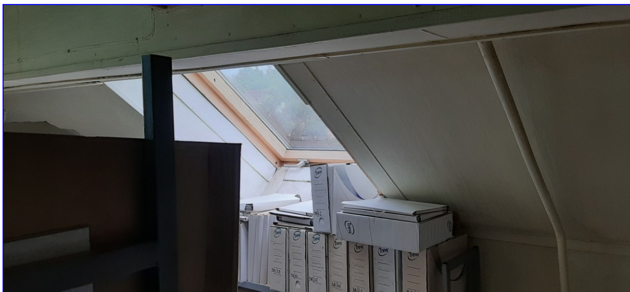
Widok zabudowanej części poddasza.
