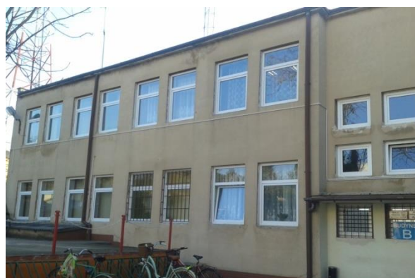
Fot. nr 5. Budynek „B” Urzędu Gminy Bobrowniki (w obszarze rewitalizacji)
