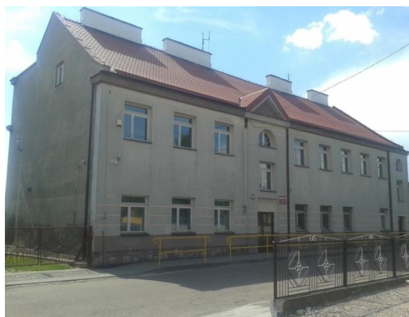
Fot. nr 3. Budynek Gimnazjum im. Ziemi Dobrzyńskiej w Bobrownikach (w obszarze rewitalizacji)
