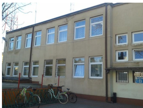
Fot. nr 5. Budynek „B” Urzędu Gminy Bobrowniki (w obszarze rewitalizacji)
