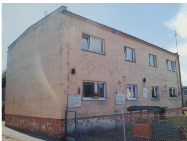
Fot. nr 2. Budynek Przedszkola Samorządowego w Bobrownikach, ul. Włocławska 10 (poza obszarem rewitalizacji)
