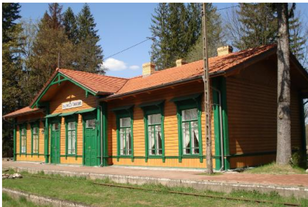
Zdjęcie 12. Dawny dworzec kolejowy Białowieża Towarowa - Restauracja „Carska”
