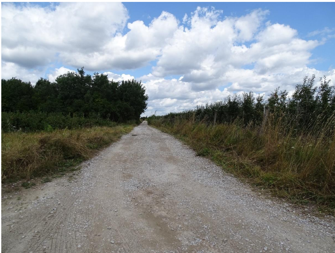
Perspektywa drogi dojazdowej (działka ewidencyjna Nr 78) w kierunku północnym.
