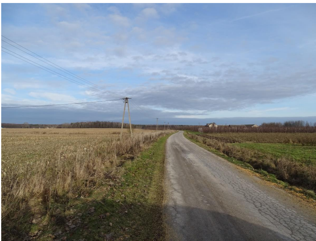
Zdjęcie Nr 9. Perspektywa drogi dojazdowej do wsi Baraki Osuchowskie w kierunku północno-wschodnim.
