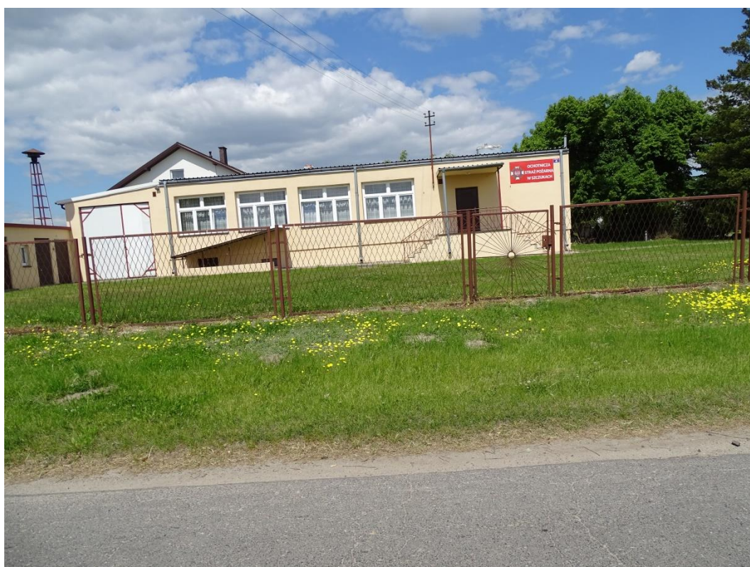
Zdjęcie Nr 2. Wieś Szczuki. Wgląd na zabudowę usługową z drogi powiatowej Nr 4126E w kierunku północno-wschodnim.
