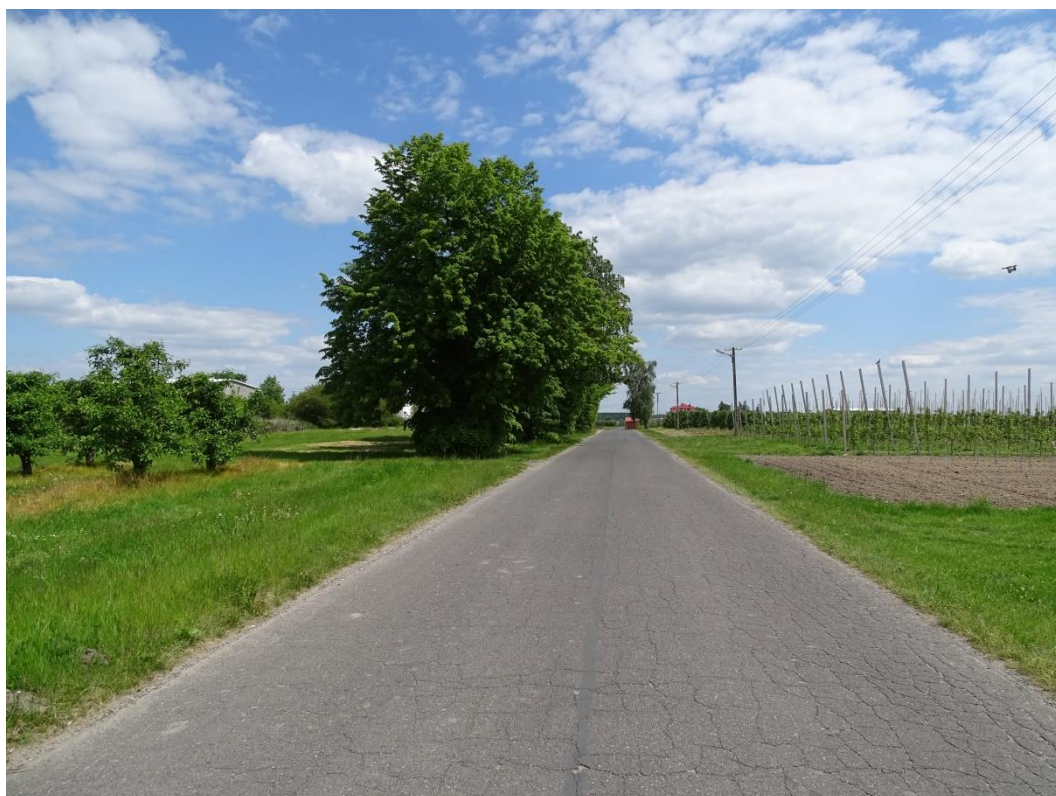
Zdjęcie Nr 4. Wieś Szczuki. perspektywa drogi powiatowej Nr 4126E w kierunku południowo-wschodnim. Po stronie lewej obszar opracowania.
