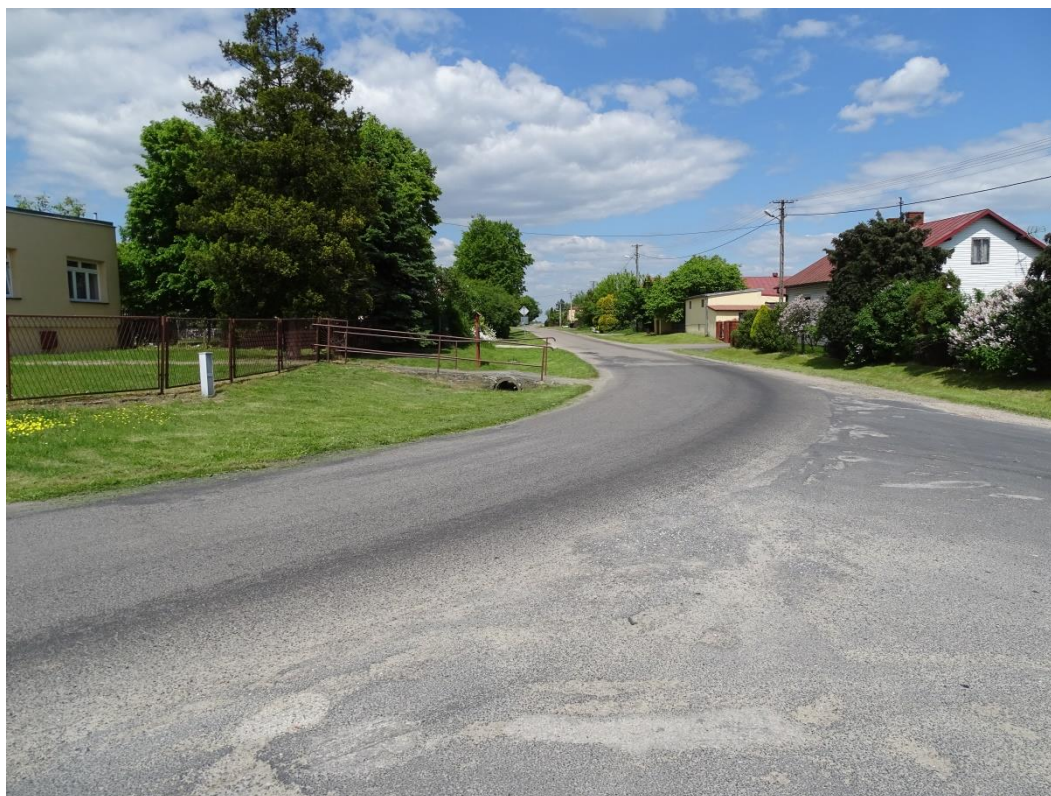
Zdjęcie Nr 5. Wieś Szczuki. perspektywa drogi powiatowej Nr 4123E w kierunku północno-wschodnim. Po stronie lewej zabudowa usługowa na obszarze opracowania.
