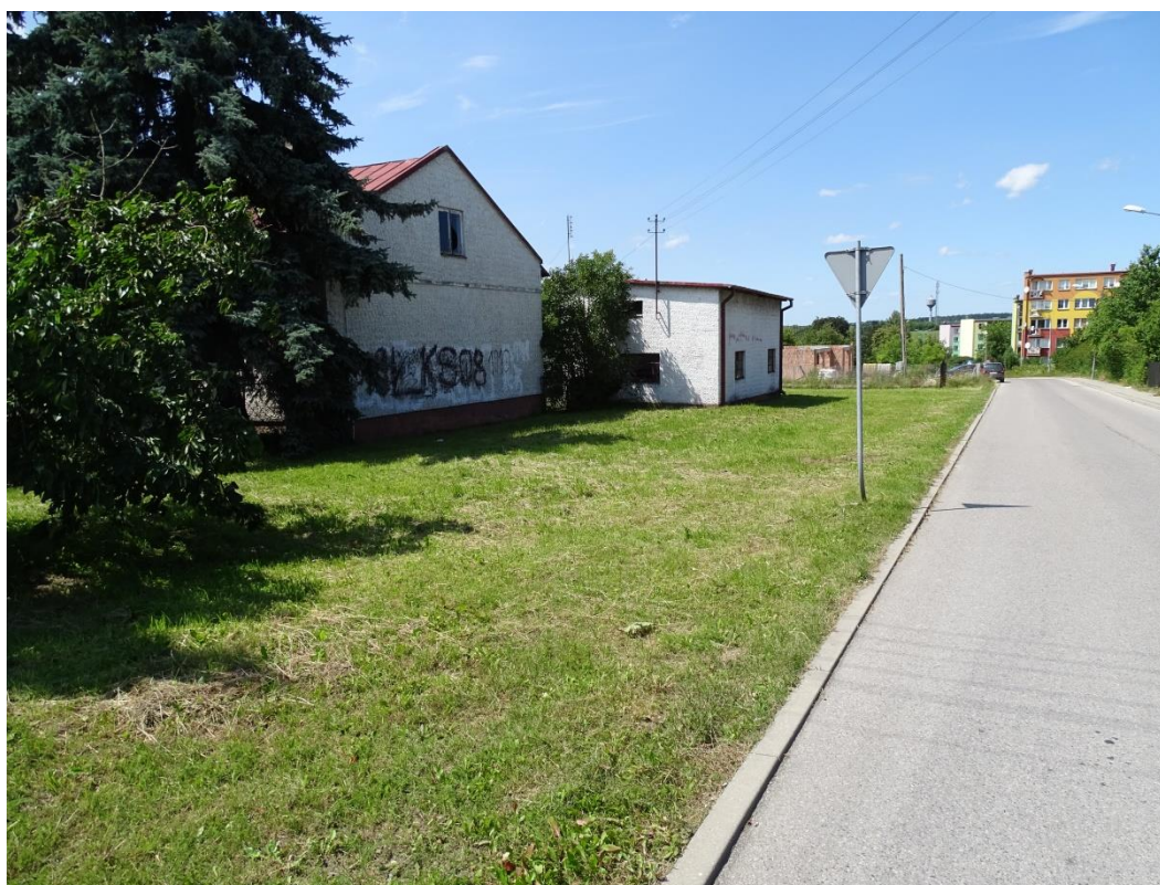
Zdjęcie Nr 1. Obszar zachodni. Wgląd na zabudowę na działce Nr 175/20 i drogę osiedlową z drogi powiatowej Nr 4101E w kierunku północno-zachodnim.
