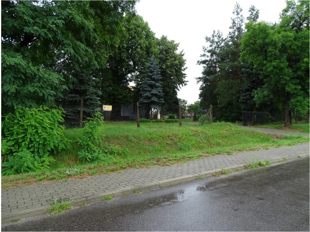
Zdjęcie Nr 7. Zabudowa plebanii na działce Nr 168, wgląd z drogi powiatowej Nr 4104E w kierunku północno-wschodnim.
