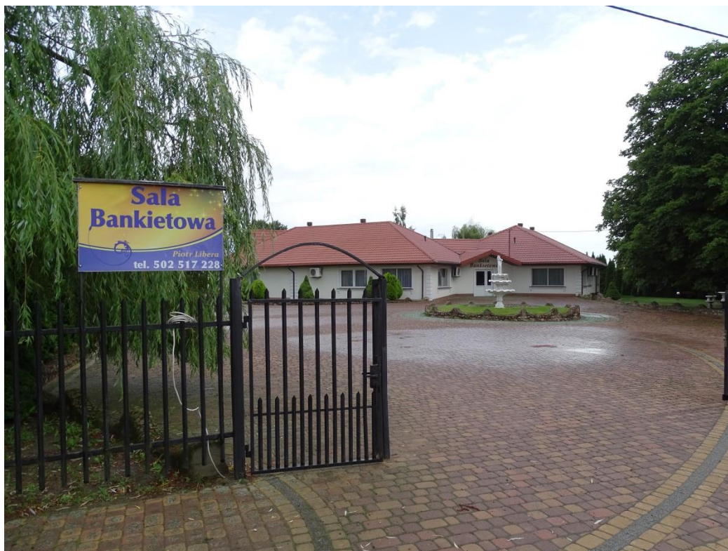
Chrzęszczew. Sala bankietowa.
