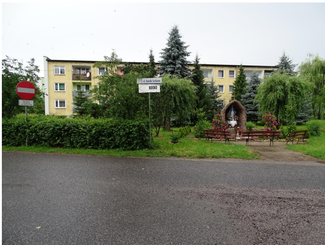
Babsk. Osiedle zabudowy wielorodzinnej.
