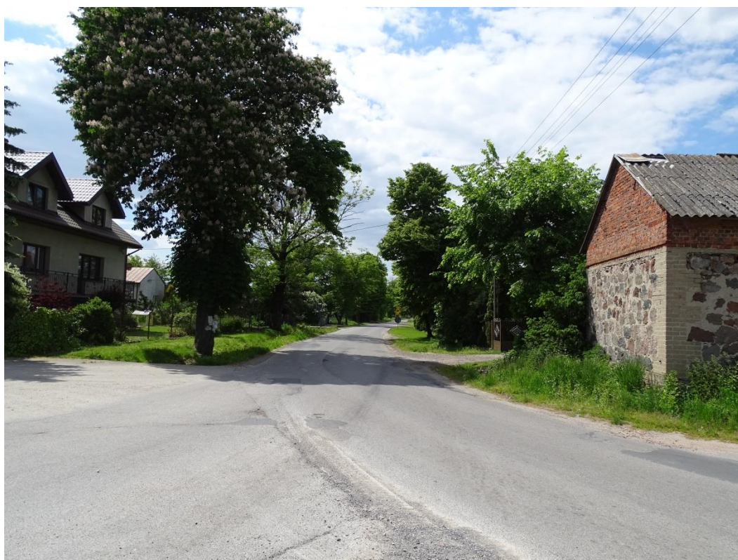
Chodnów. Droga powiatowa Nr 4127E, wgląd w kierunku zachodnim.
