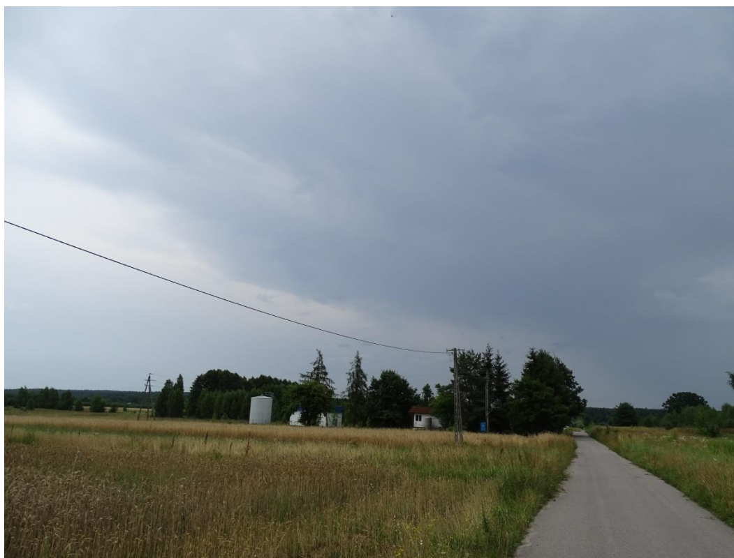
Teodozjów. Komunalne ujęcie wody.
