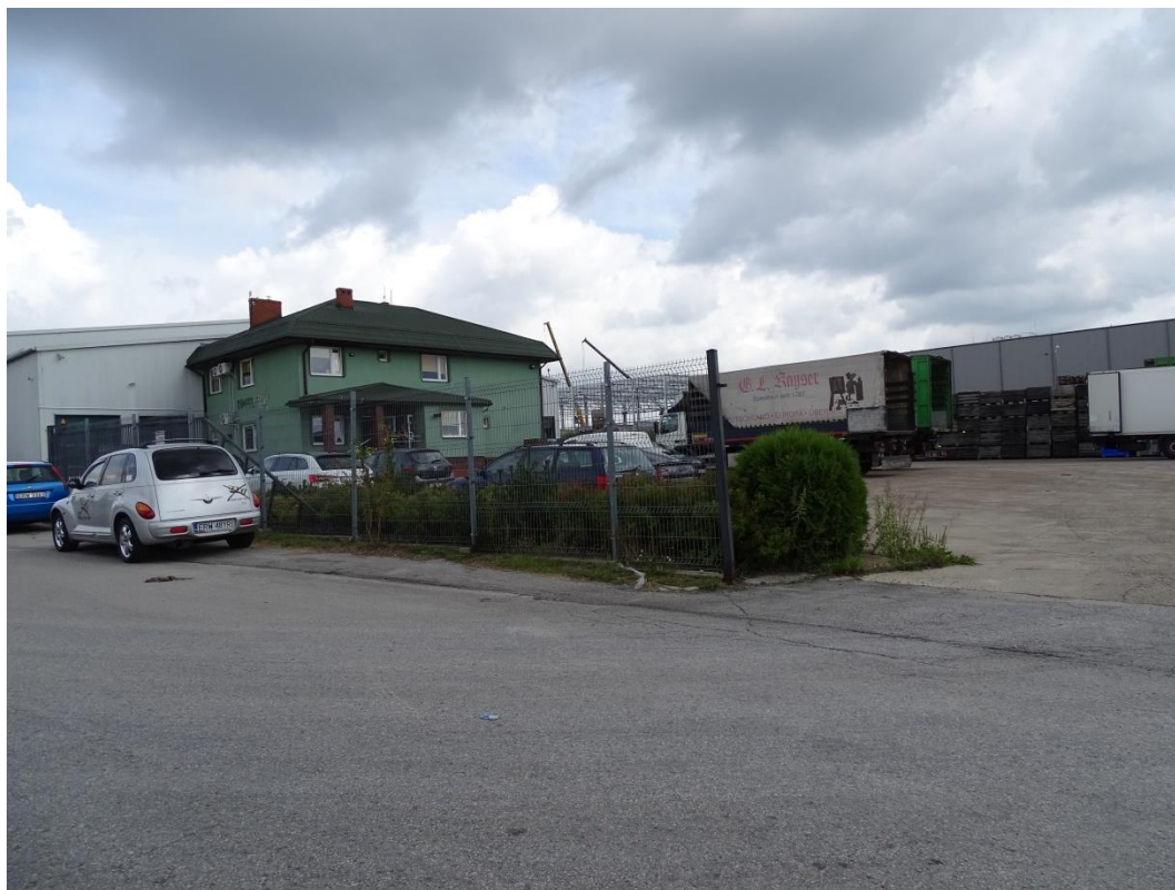
Biała Rawska. Zabudowa produkcyjno-magazynowa „Kam Pol” rozbudowa od strony ul. Targowej.
