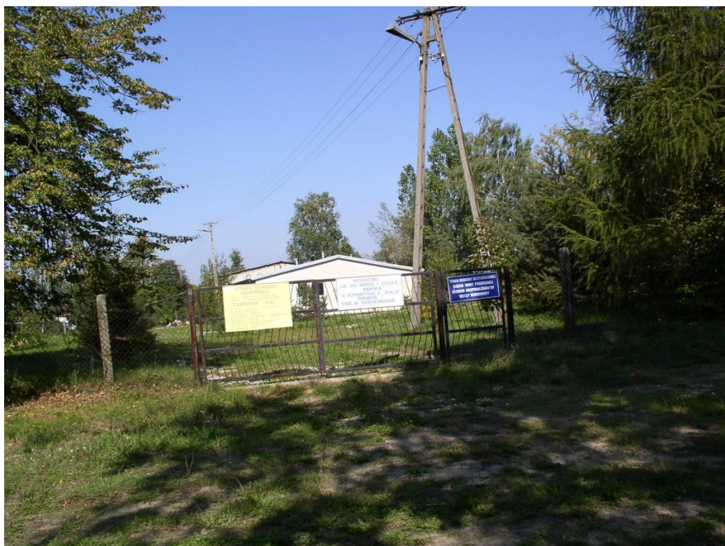
Babsk. Ujęcie wody.
