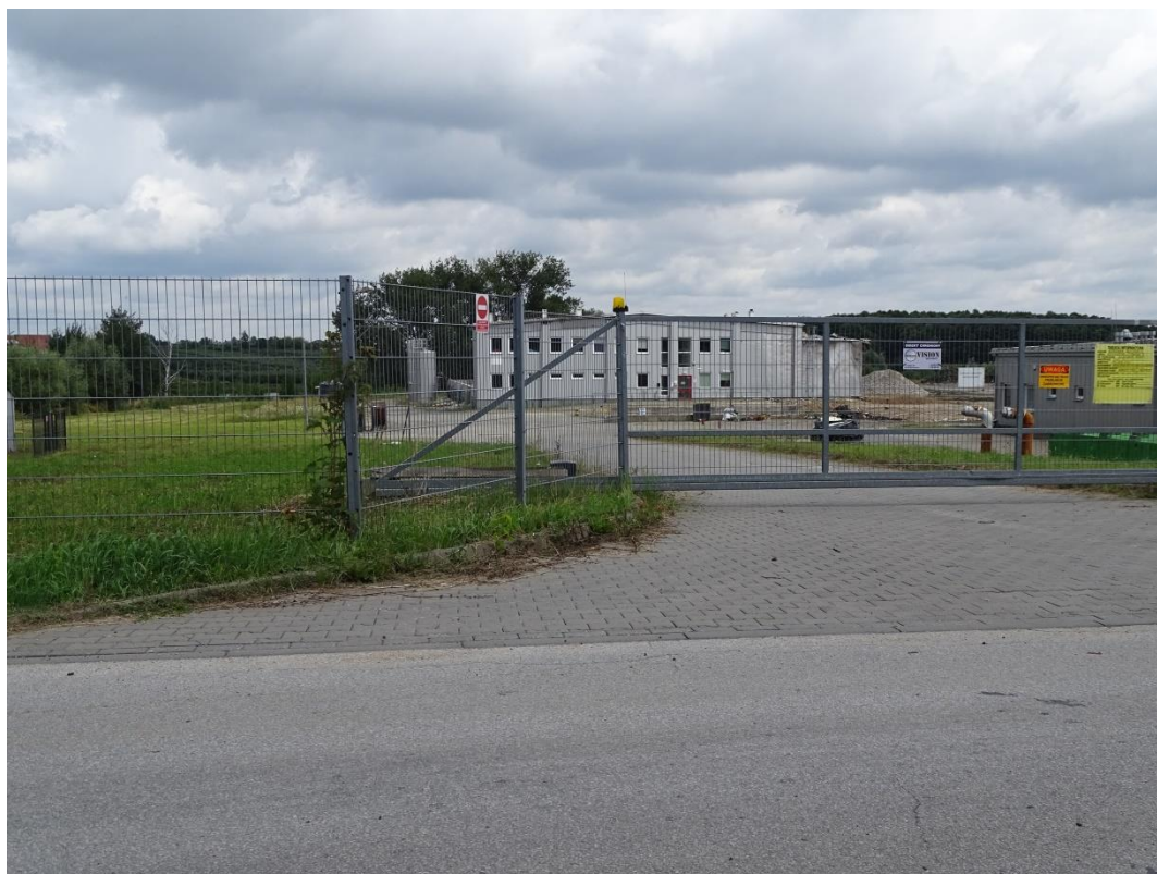
Biała Rawska. Zabudowa produkcyjno-magazynowa (POLA) w budowie przy ul. Targowej.
