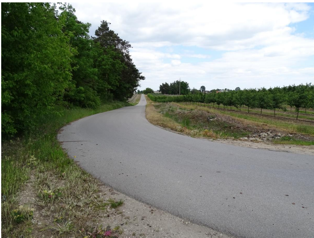
Stara Wieś. Droga gminna Szwejki Małe – Stara Wieś.
