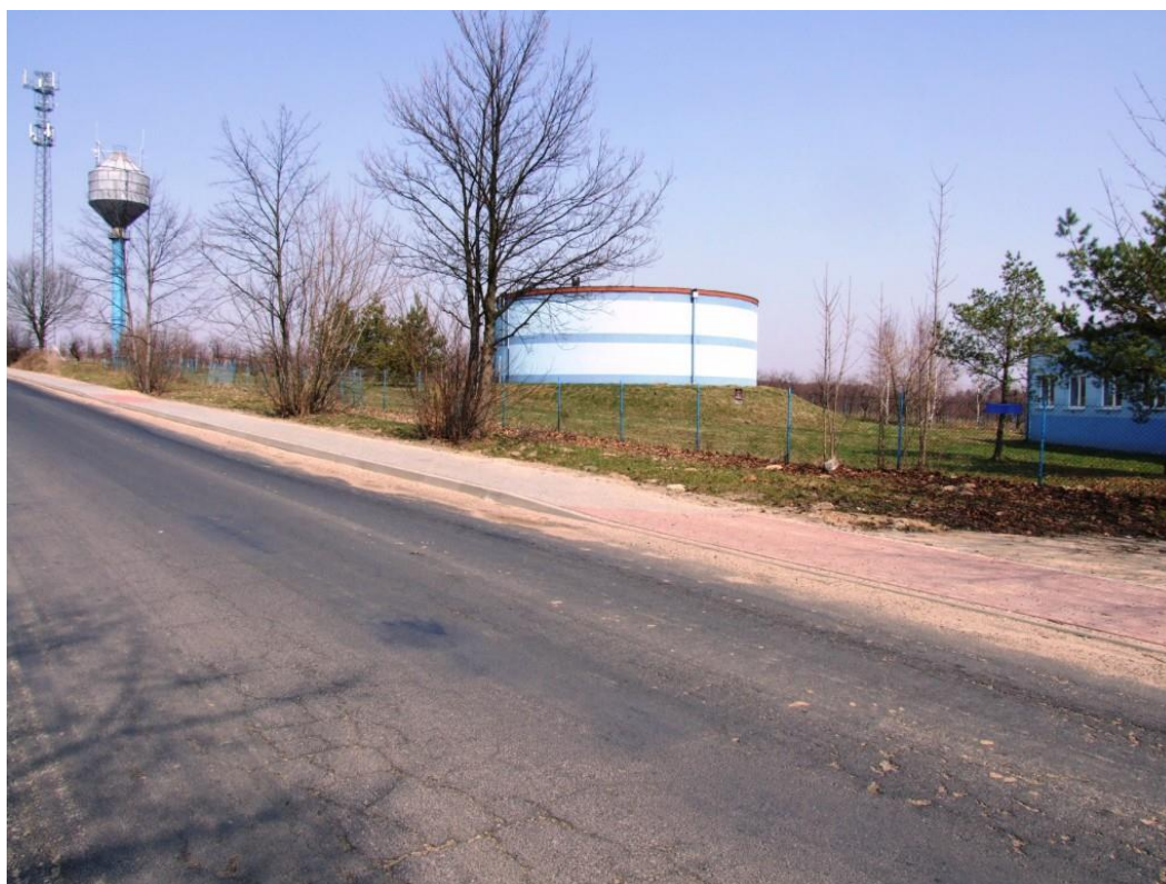
Biała Rawska. Wodociągowa wieża ciśnieniowa i stacja bazowa telefonii komórkowej w rejonie stacji uzdatniania wody.
