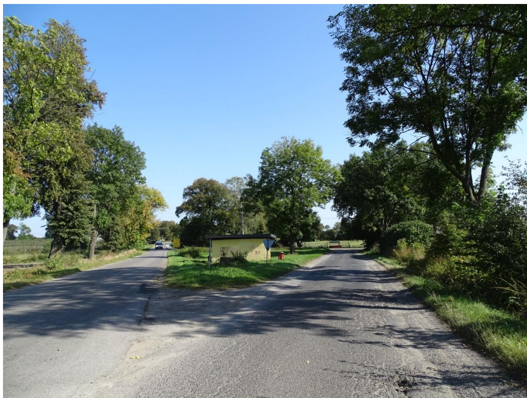
Stara Wieś. Skrzyżowanie dróg Nr 4126E i 4127E.
