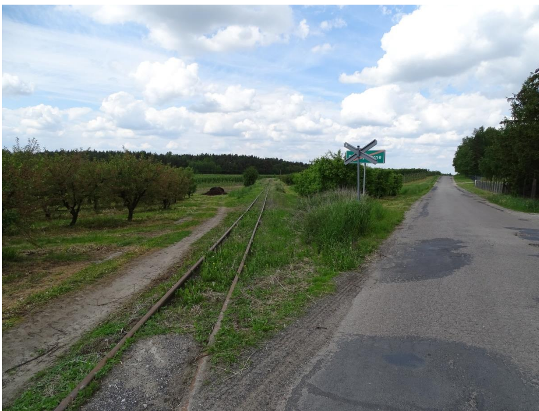
Porady Górne. Kolejka wąskotorowa na przecięciu z drogą powiatową Nr 4120E. Wgląd w kierunku północnym.
