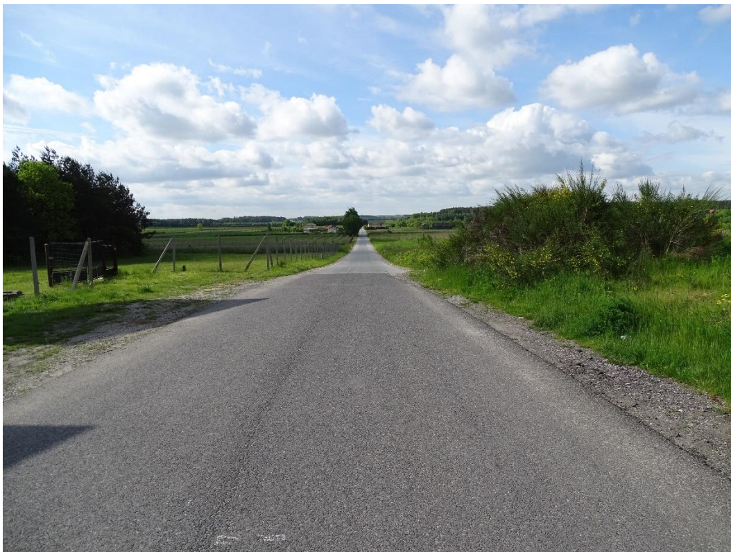
Droga powiatowa Nr 4306E. Wgląd z drogi Nr 725 w kierunku południowym.
