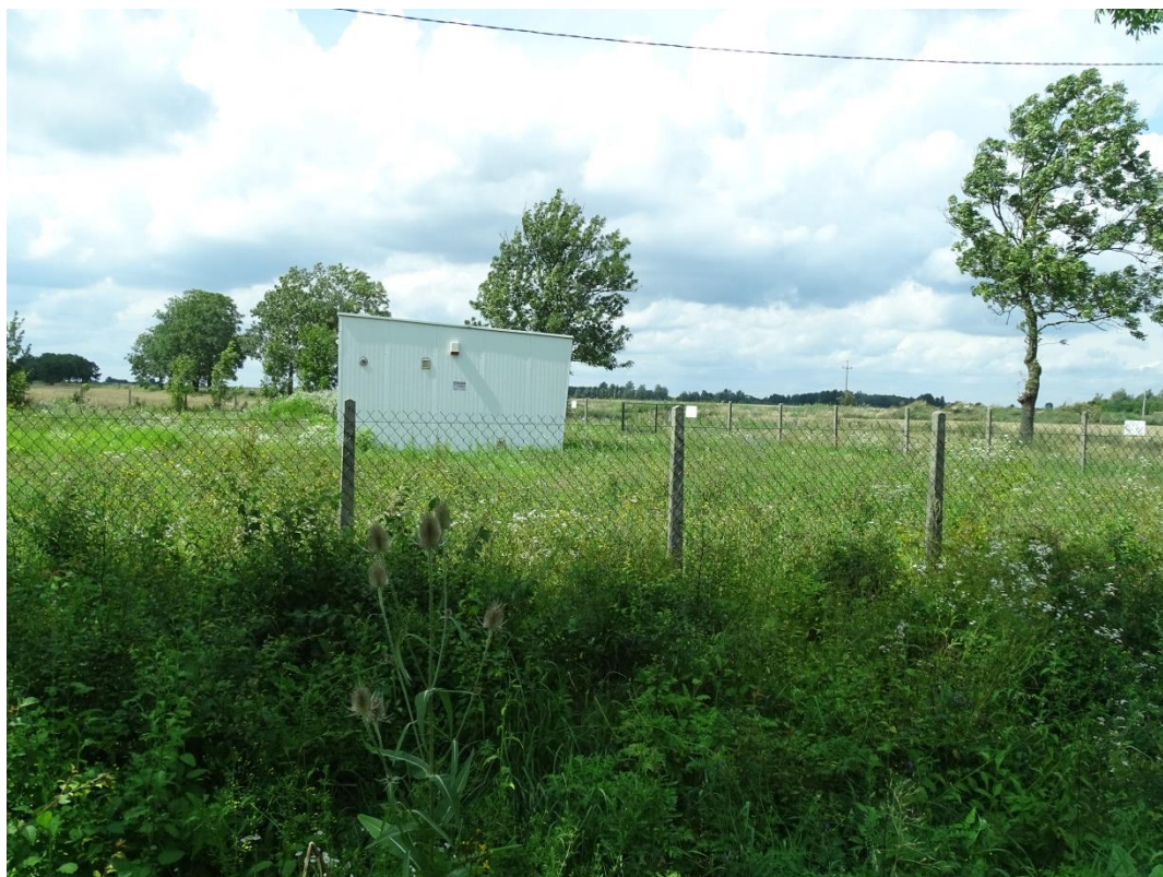
Tuniki Małe. Ujęcie wody.
