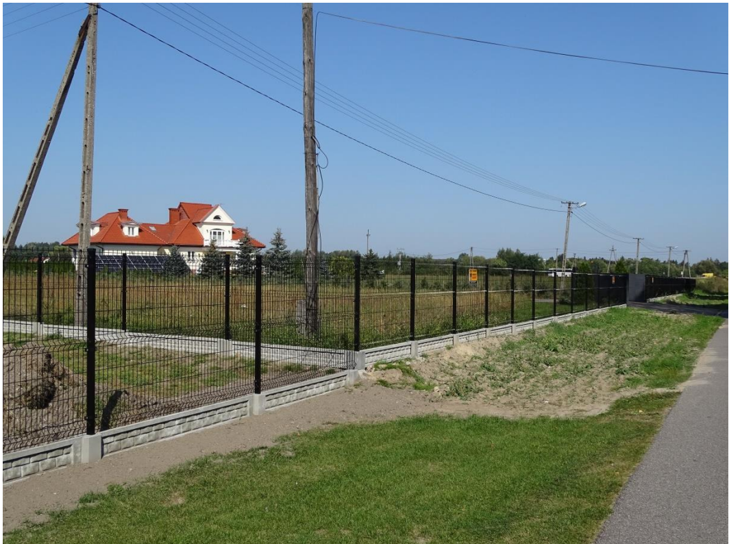
Zdjęcie Nr 9. Obszar B – Żurawia. Wgląd na zabudowę i ogrody (rejon działki Nr 129/8) od strony drogi gminnej w kierunku północno-wschodnim.
