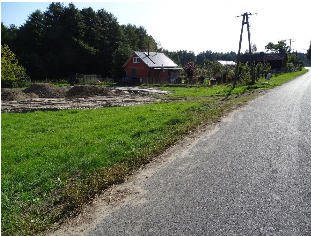
Zdjęcie Nr 15. Obszar C – Rzeczków. Wgląd na zabudowę w rejonie działek Nr 107 i 110 z drogi dojazdowej w kierunku południowym.
