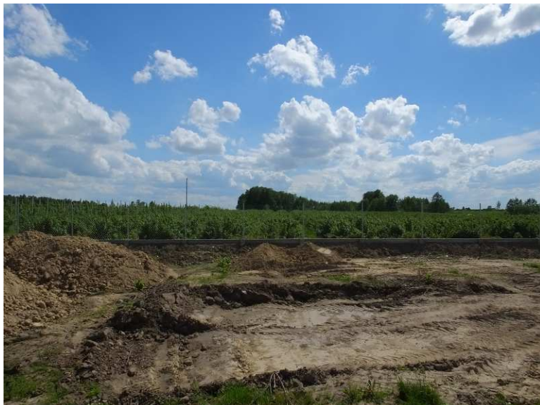
4. Fot. 4 Widok na teren przeznaczony pod projektowaną inwestycję (w oddali – uprawy sadownicze na działce inwestycyjnej)
