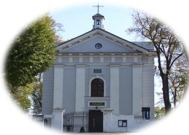
Wymagający zabezpieczeń kościół w Babsku
