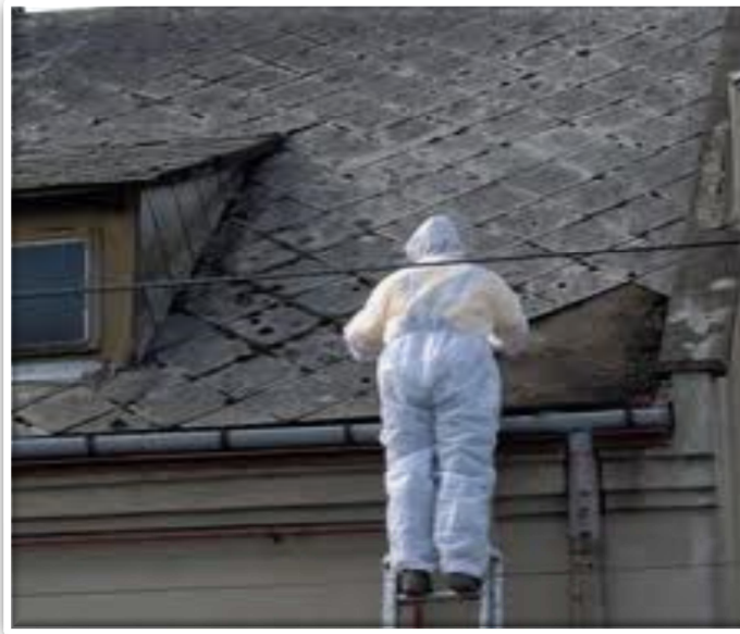
Zdjęcie 3 Płyty płaskie prasowane tzw. szablony lub płyty „karo”
