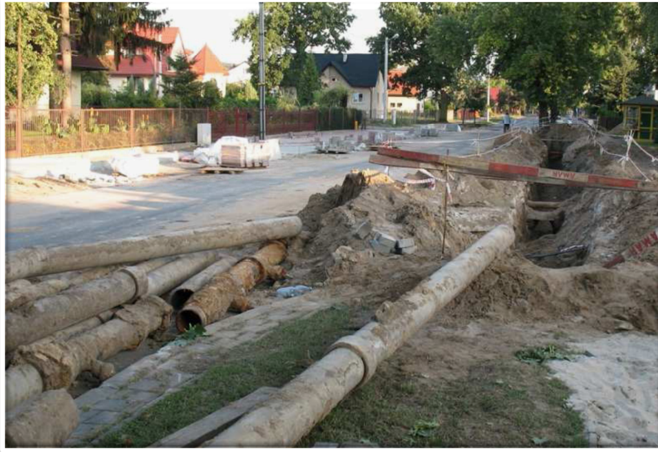
Zdjęcie 4 Rury azbestowo-cementowe
