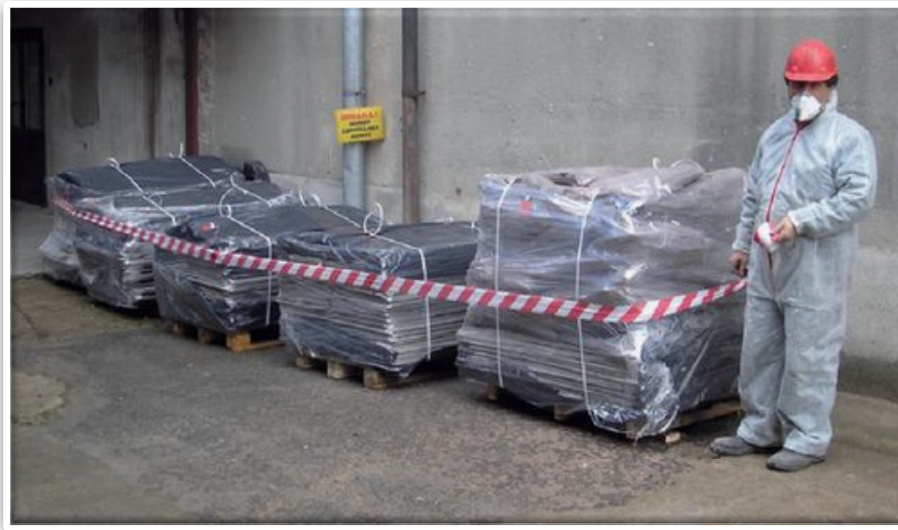
Zdjęcie 11 Usunięte płyty eternitowe odpowiednio zabezpieczone folią polietylenową
