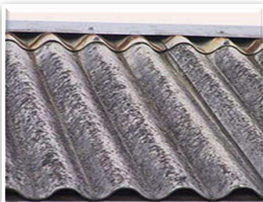
Zdjęcie 2 Płyty faliste azbestowo- cementowe
