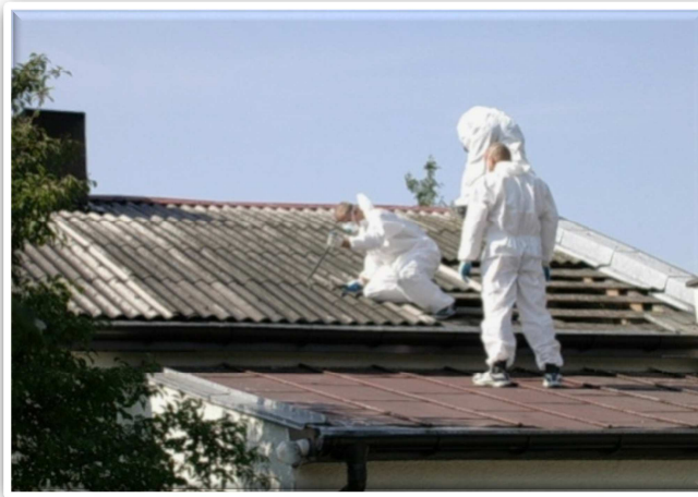
Zdjęcie 9 Przykład prawidłowego postępowania przy demontażu pokrycia dachowego z eternitu, pracownik ubrany w pyłoszczelny kombinezon z maską posługuje się specjalistycznym odkurzaczem z filtrem HEPA
