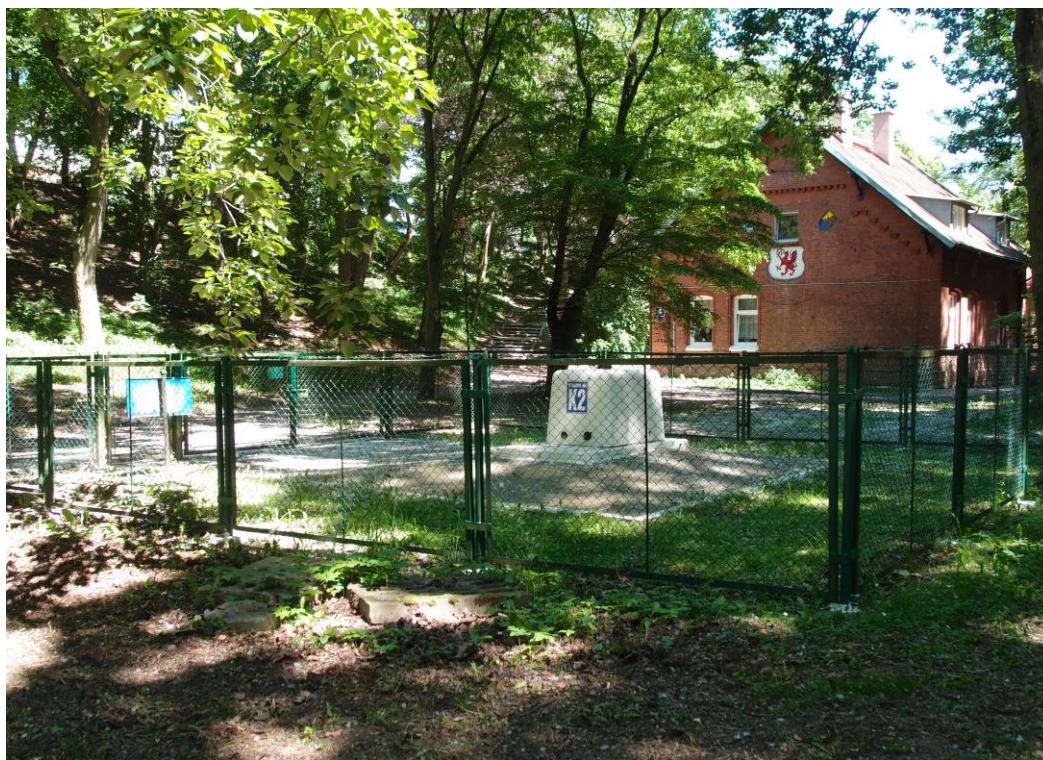
Rysunek 5. Studnia głębinowa Nr K2 w ujęciu „Park” w Tczewie.
