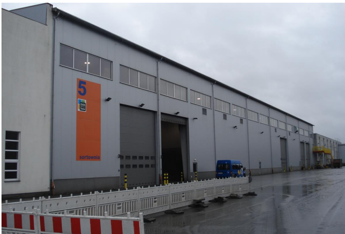
Rysunek 7. Hala sortowni odpadów na terenie Zakładu Utylizacji Odpadów Stałych Sp. z o.o.
