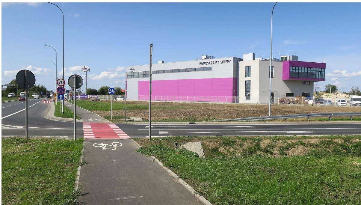
Fot. 12. Przykład wdrożenia organizacji ruchu proponowanej na rys. 22C. Węzeł „Rybitwy” na drodze ekspresowej S7 w Krakowie. Po prawej podporządkowany wlot łącznicy węzła typu WB w rondo turbinowe, widoczne oznakowanie P-15 na jezdni łącznicy. Droga dla rowerów przecina wlot na pierwszeństwie, w cieniu pojazdów opuszczających rondo turbinowe wylotem w ul. Tadeusza Śliwiaka.
