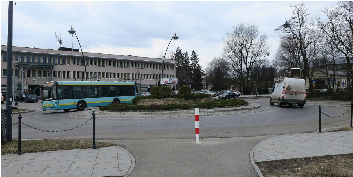
Fot. 14. Droga dla rowerów jako samodzielny wlot małego ronda. Optymalna geometria i niestety całkowity brak oznakowania (znaki A-7 i C-12 na wlocie ronda są niezbędne!). Skrzyżowanie ulic Grunwaldzkiej i Pocztowej, Jaworzno.
