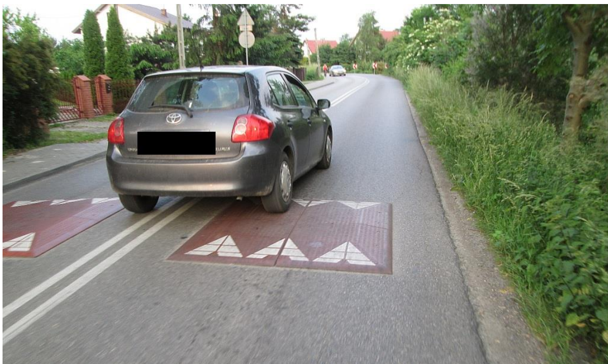
Fot. 2. Przykład uspokojenia ruchu przy pomocy prawidłowo umieszczonych progów wyspowych (niemożliwe jest ominięcie progu samochodem przez jazdę środkiem jezdni – widoczny na zdjęciu pojazd przekracza linię P-4, bo wcześniej wyprzedził rowerzystę). Piekary koło Krakowa.
