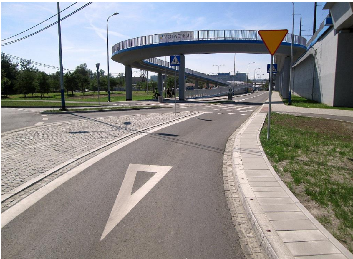
Fot. 16. Poprawne oznakowanie przejazdu dla rowerzystów przecinającego łącznicę („bypass”). Za znakiem poziomym P-15 i pionowym A-7 widać znak D-6b który nie ustala pierwszeństwa i jest jedynie znakiem informacyjnym. Przed przejazdem dla rowerzystów wyznaczono linię zatrzymań złożoną z trójkątów (P-13). Kraków, ul. Saska.
