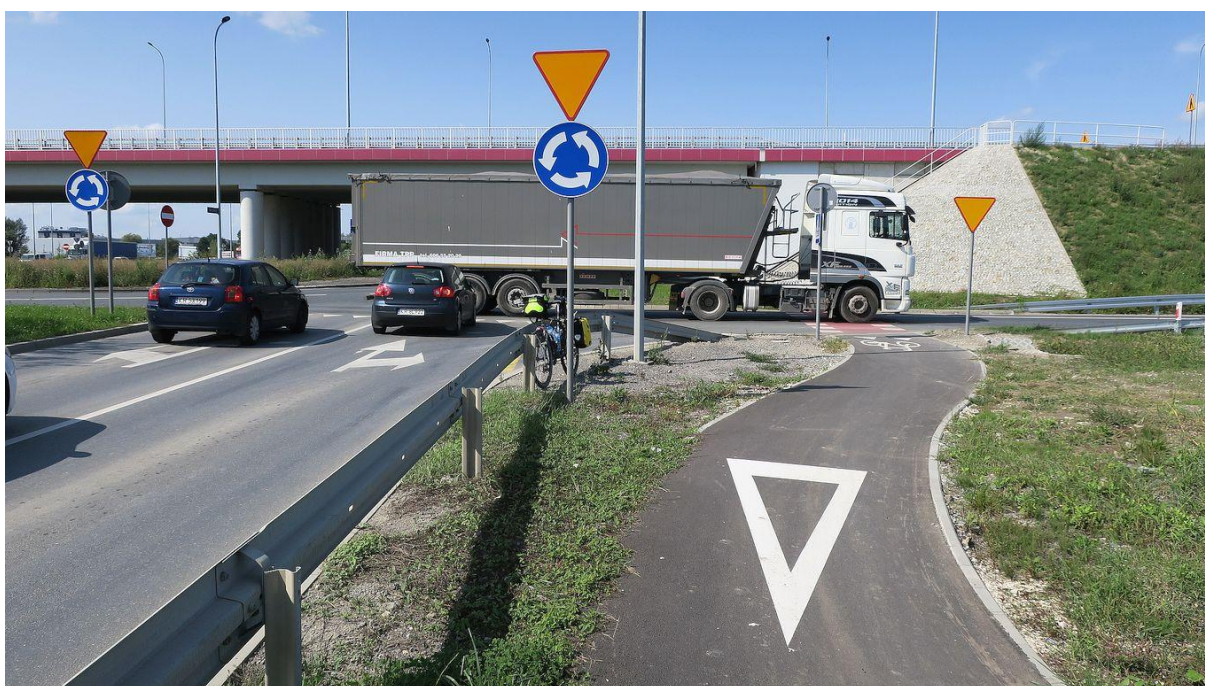
Fot. 13. Przykład wdrożenia organizacji ruchu proponowanej na rys. 22C. Węzeł „Rybitwy” na drodze ekspresowej S7 w Krakowie. Widok z wlotu ul. Trakt Papieski w rondo turbinowe. Widoczne oznakowanie A-7 i P-15 na drodze dla rowerów przecinającej wylot ronda turbinowego.
