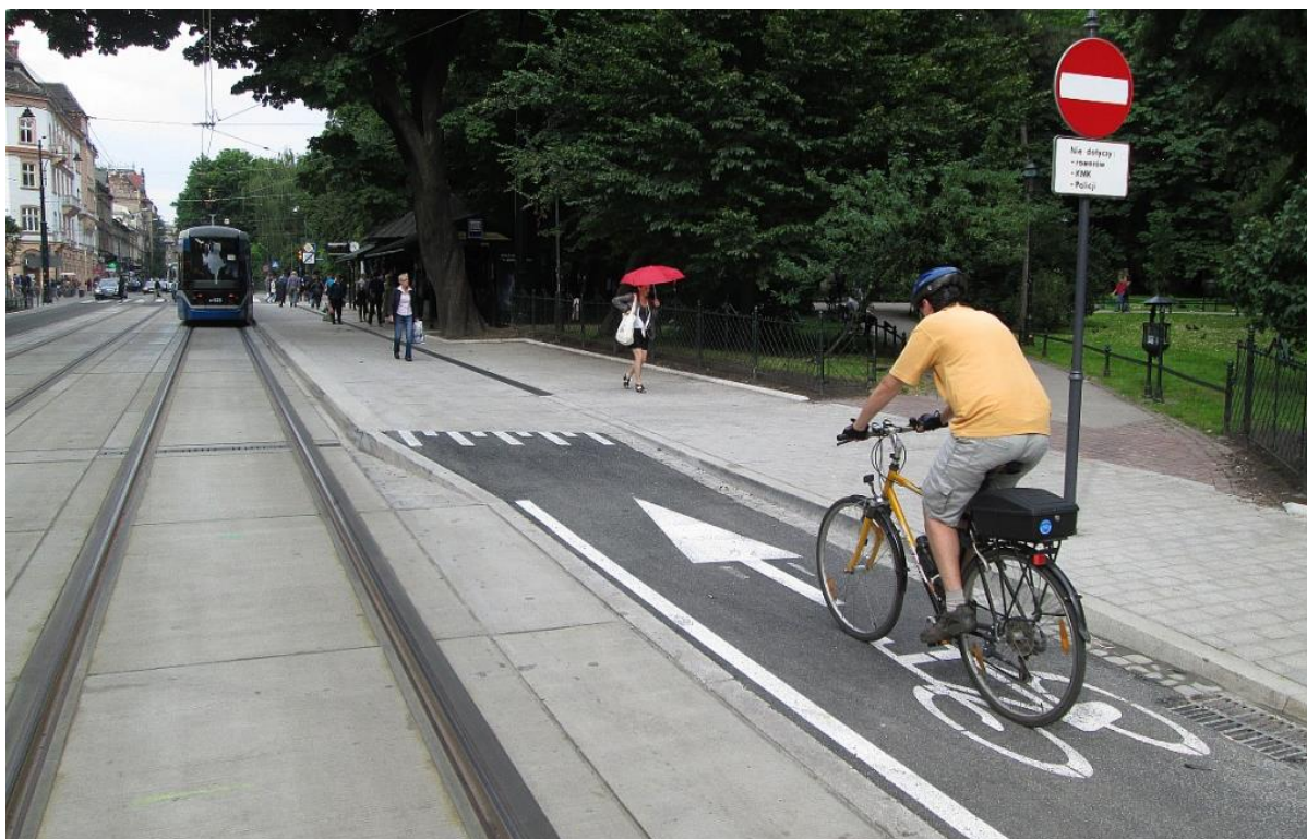
Fot. 4. „Przystanek wiedeński” zlokalizowany w przedłużeniu pasa ruchu dla rowerów (kontrapasa). Ze względu na wspólny ruch tramwajów i autobusów zastosowano krawężnik typu „kassel” umożliwiający bezpieczny dojazd autobusu do krawędzi. Kraków, ul. Podwale.
