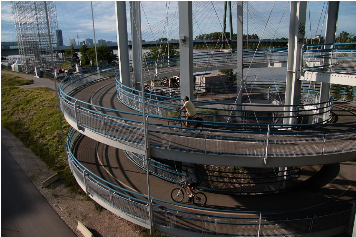
Fot. 18. Pochylnia ślimakowa prowadząca z brzegu Dunaju na drogę dla rowerów zlokalizowaną w dolnym poziomie mostu Praterbrücke. Widoczna prawidłowa orientacja pochylni: w lewo w dół, zapewniająca większy promień łuku rowerzystom jadącym z większą szybkością w dół i minimalizująca ryzyko kolizji. Zwraca uwagę wysoko umieszczona poręcz balustrady. Wiedeń, Austria.
