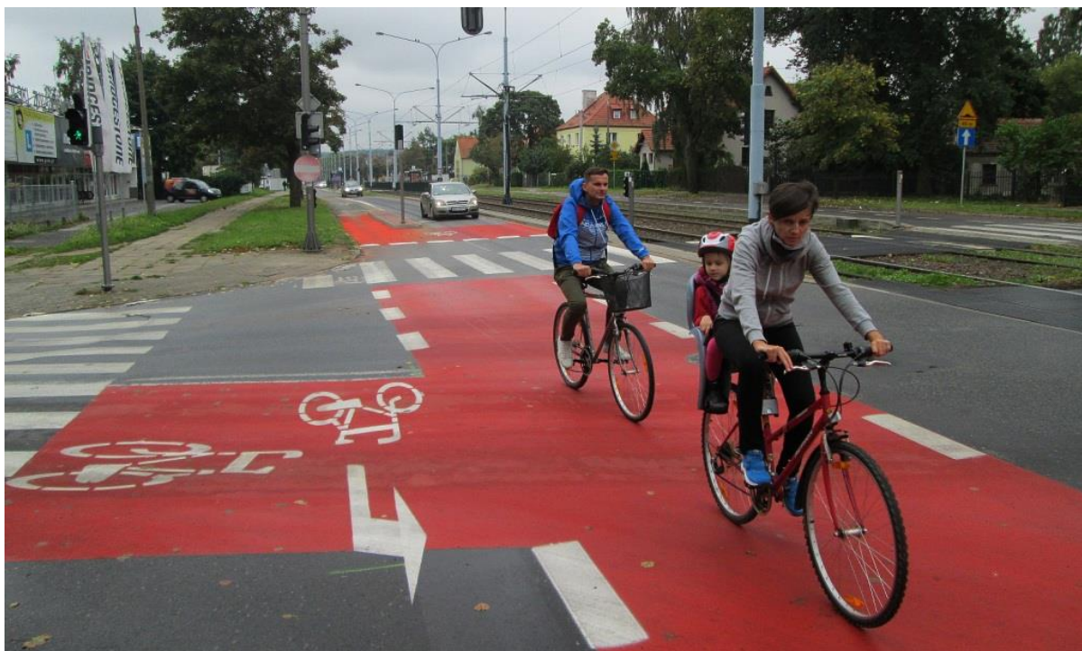
Fot. 11. Śluza typu 2, Gdańsk, ul. Wojska Polskiego. W głębi widoczna na wlocie śluza klasyczna, typu 1. Uwaga: zdjęcie przedstawia rozwiązanie eksperymentalne (rok 2013). W niniejszych standardach proponuje się nieco inne oznakowanie poziome śluzy typu 2, zgodnie z przepisami po nowelizacji z 2015 roku (D.U.2015.1314).
