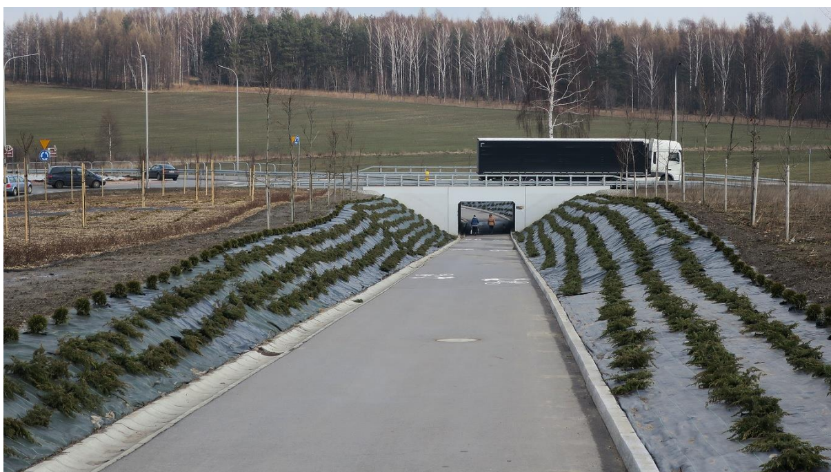
Fot. 19. Bezkolizyjne rozwiązanie ruchu rowerowego – tunel pod wlotem ronda. Rondo im. Lecha i Marii Kaczyńskich, skrzyżowanie ul. św. Wojciecha i Obwodnicy Północnej, Jaworzno.
