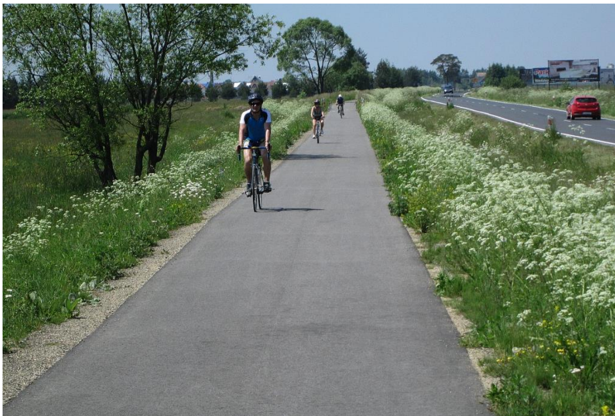
Fot. 6. Droga dla rowerów o nawierzchni asfaltowej wykonana na poszerzonej podbudowie, bez zbędnych i podnoszących koszty obrzeża lub krawężników. Droga wojewódzka nr 957, fragment trasy rowerowej euroregionu Tatry Nowy Targ – Sucha Hora/Trstena (Słowacja).
