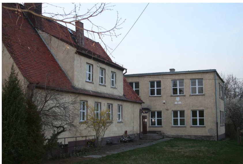
Wodok na budynek szkoły – strona wschodnia
