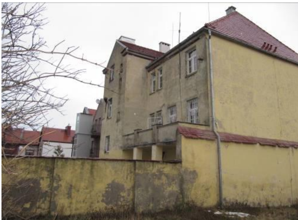
Widok elewacji zachodniej i południowej
