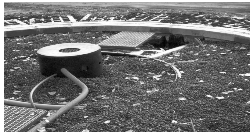
Oczyszczalnia hydroponiczna w Sendeniu, gm. Łąck.
