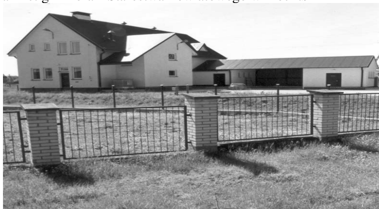
Oczyszczalnia ścieków typu BIOVAC w Nowym Duninowie.
