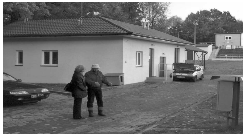
Oczyszczalnia ścieków w Miszewie Murowanym, gm. Bodzanów.
