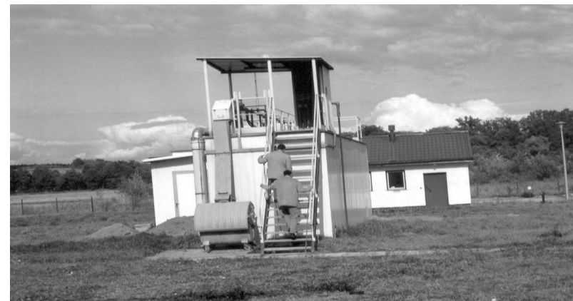
Oczyszczalnia ścieków przed rozbudową w Brudzeniu Dużym.
