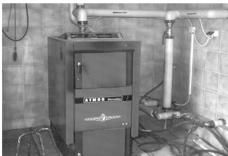
Piec na odpady drzewne w Modelowym Wiejskim Centrum Ekoturystyki w Sendeniu, gm. Łąck.
