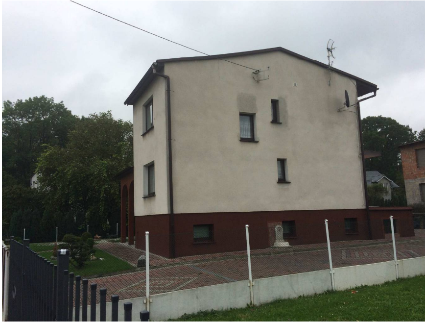
Fot. Nr 2. Budynek nr 56. Przyłącze elektroenergetyczne do odtworzenia po przebudowie.
