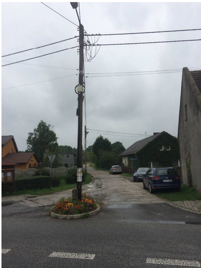
Fot. Nr 1. Stanowisko słupowe nr 29 – do przebudowy.
