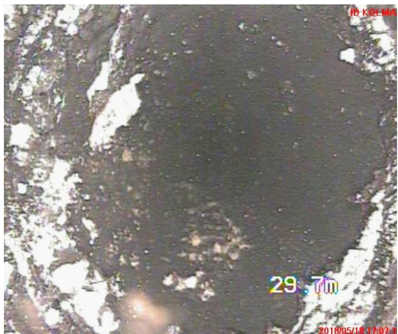
Pokryta osadami rura nadfiltrowa.
