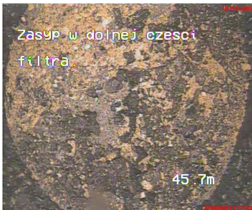
Nagromadzone osady w dolnej części filtra.
