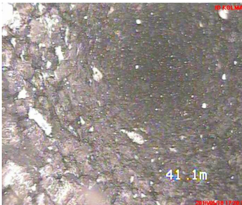
Pokryte warstwą inkrustacji wewnętrzne ściany i szczeliny filtra.
