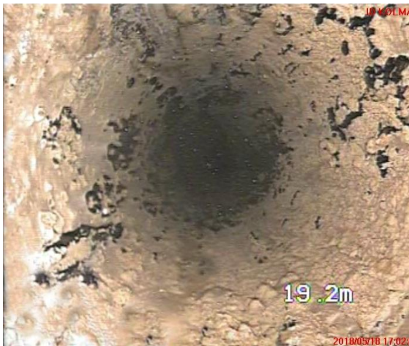
Pokryta osadami rura nadfiltrowa.
